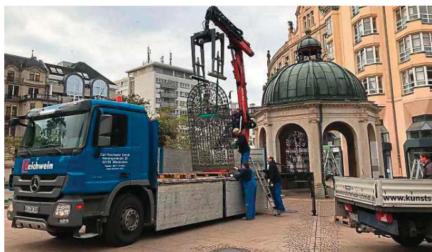
Das Kochbrunnen-Tempelchen soll aus seinem Dornröschenschlaf geweckt werden, es wird komplett saniert. Foto: Christoph Krämer
